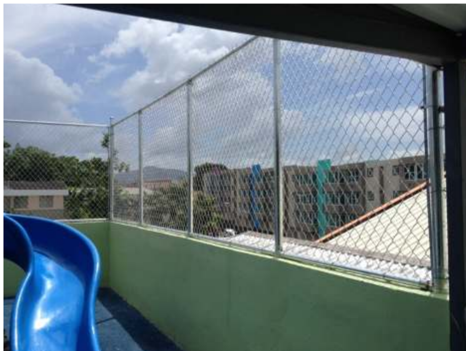
Reparación de verja en Caguas Centro
