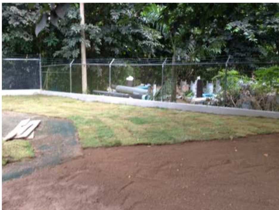
Reparación de patio en Di Valore
