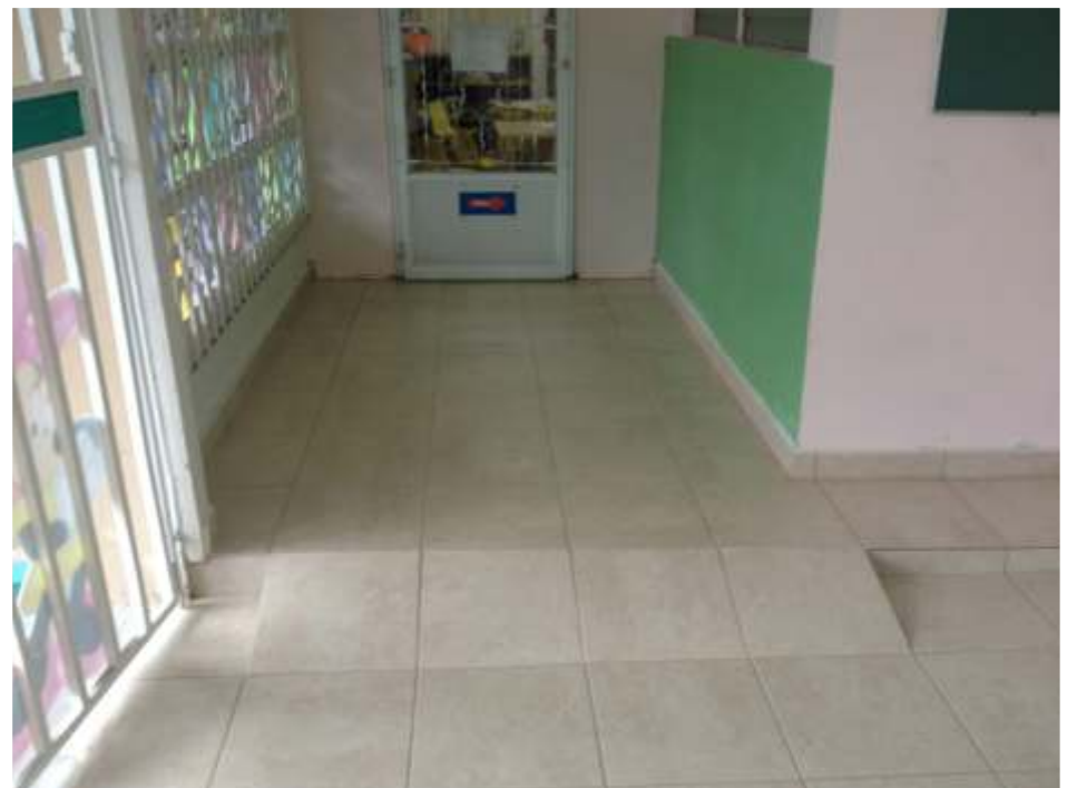
Reparación de piso en Comandante II
