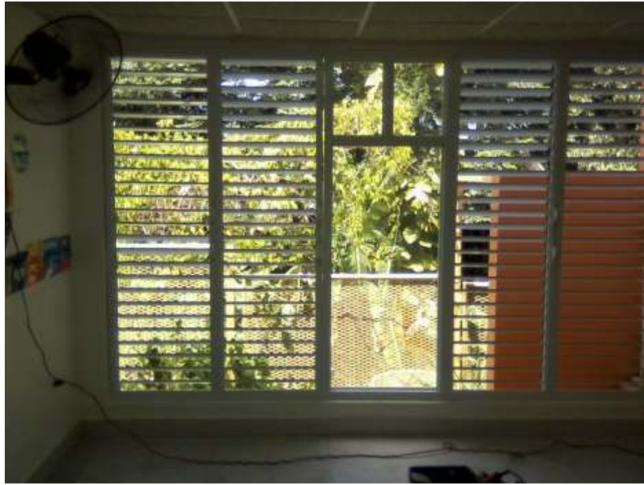
Ventanas panorámicas Centro Oficina Central
