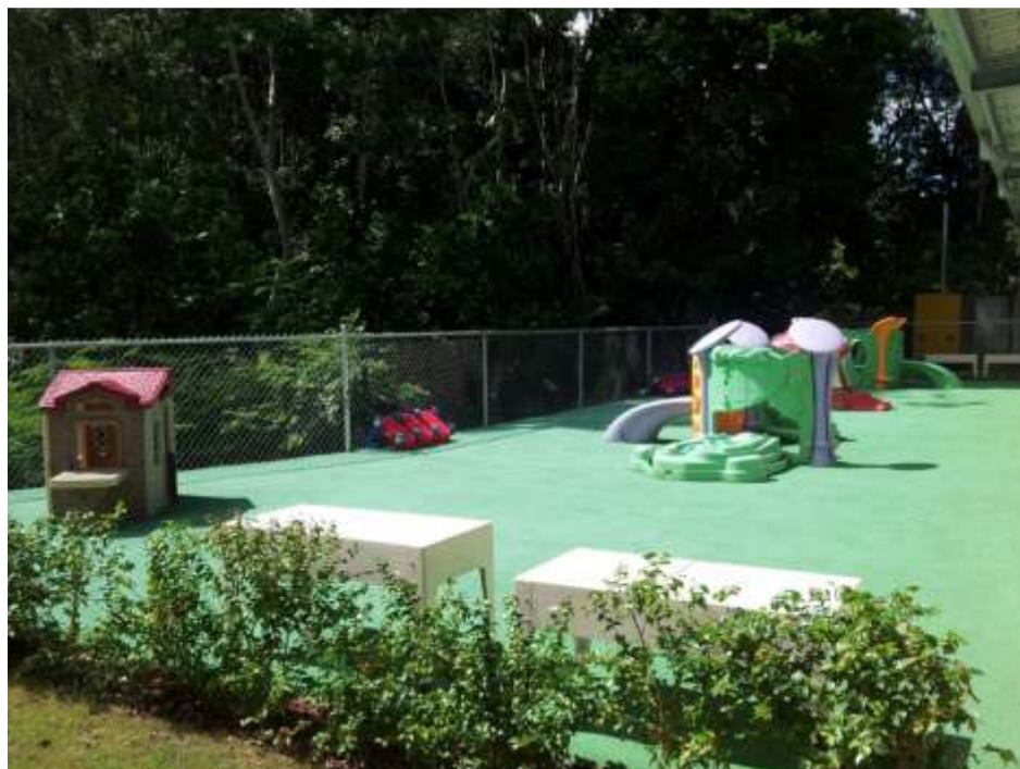
Reparación de patio en Early Head Start
